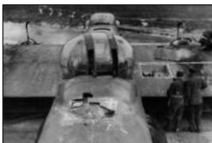
Schade aan Lancaster bij terugkomst.
