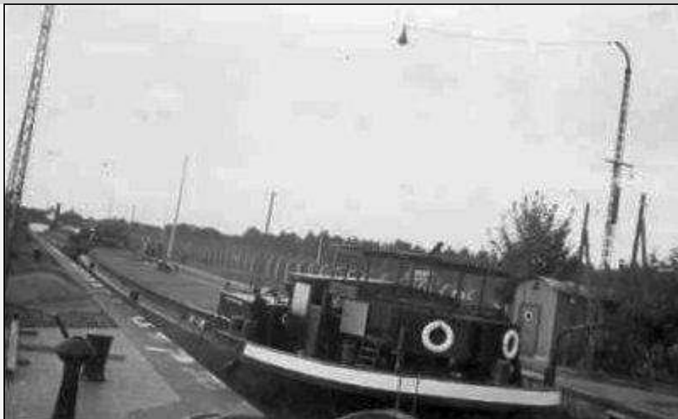
Een van de sluisen in het Dortmund-Ems Kanal , circa 1943
